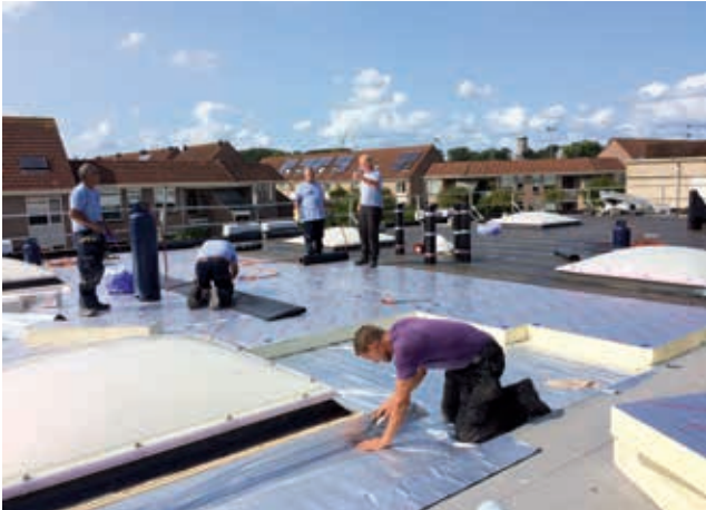
Het oude dakpakket is vervangen door 140 mm dikke een dampremmende laag, PIR isolatie met een Rc-waarde van ongeveer 6 W/m 2 K en twee lagen bitumineuze dakbedekking.
