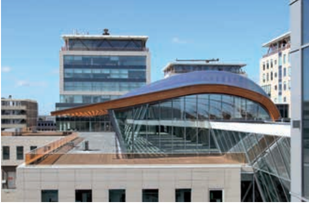
De luchtkussens zijn stabiel, ook bij harde wind. ETFE folie kent een hoge doorscheurweerstand.
