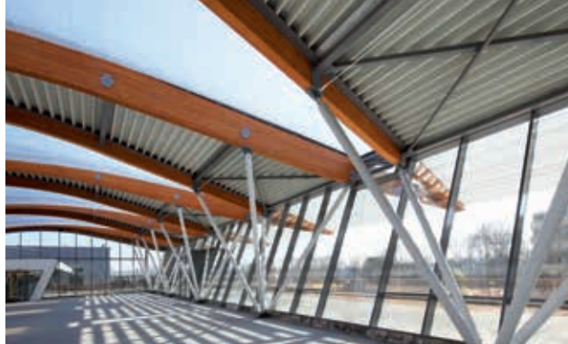
Aan de zuidzijde rusten de houten spanten op schuingeplaatste stalen kolommen.
