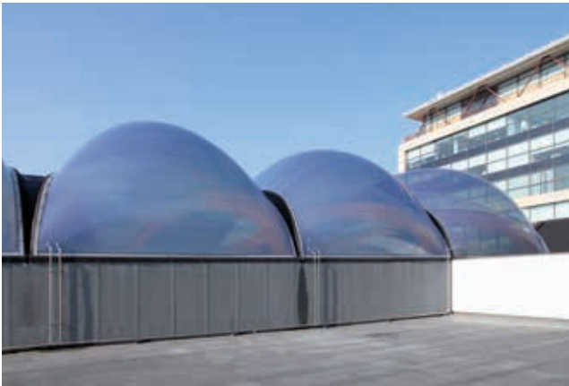
Elk van de vijf luchtkussens bestaat uit vier lagen ETFE folie van 200 micrometer dikte. Door de ruimte tussen de vier lagen folie te voorzien van overdruk, ontstaan drie luchtkamers per luchtkussen.
