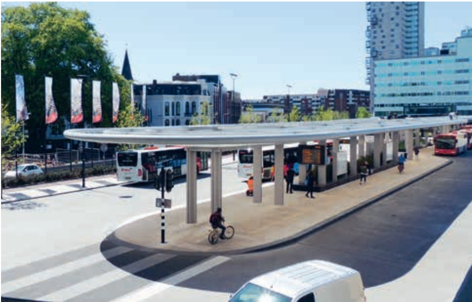
Het busstation vormt een driehoekig circuit van ruim 160 meter lang. Langs de buitenrand liggen zes instapplaatsen en één uitstapplaats.
