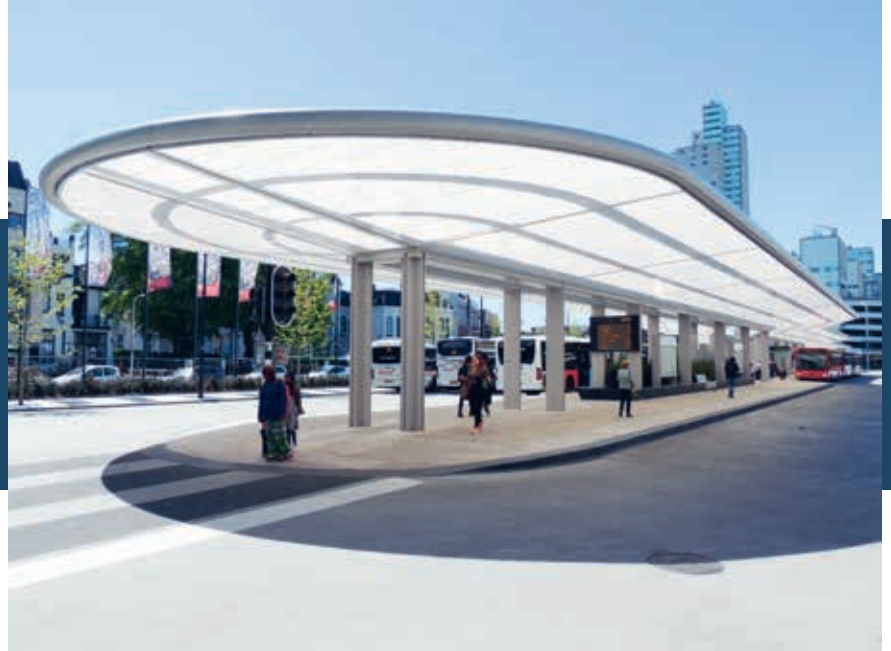
De luifel is aan de onderzijde bespannen met ETFE (ethyleen-tetrafluorethyleen copolymeer).
