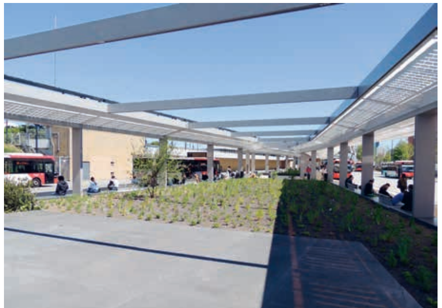
Bovenop de luifel liggen zonnepanelen met twee lagen glas waartussen kristallijnen zonnecellen gelamineerd zijn. Bij sterk daglicht creëren deze panelen een schaduwpatroon op het ETFE.
