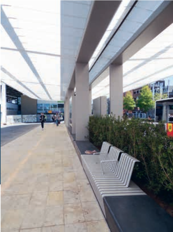
In de zitranden zijn stripstalen bankjes verwerkt met geïntegreerde verwarming.
