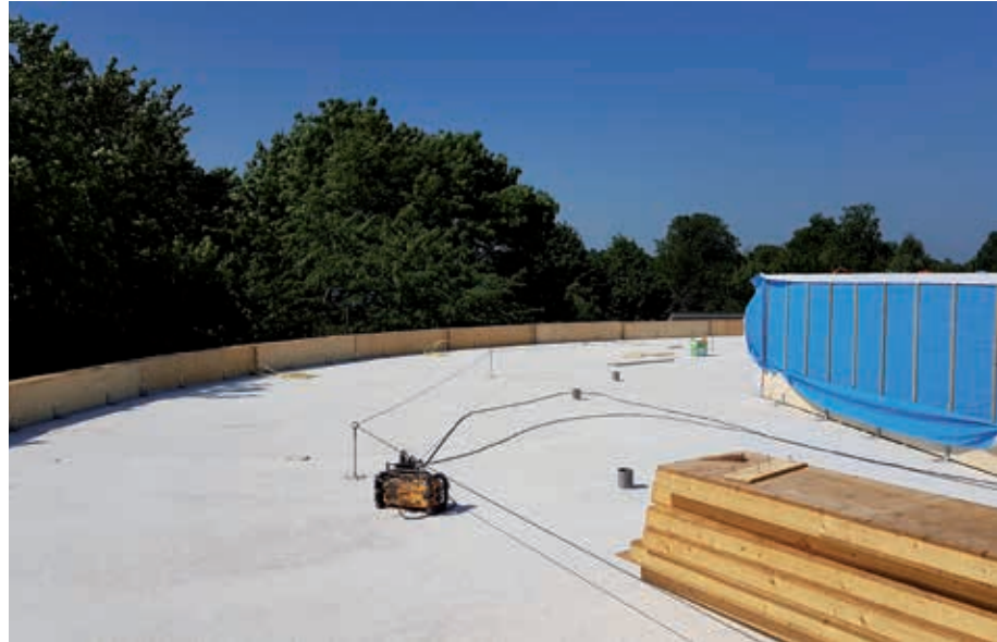
Breedplaatvloer met betonopstort en beveiligingssysteem met kabel.
