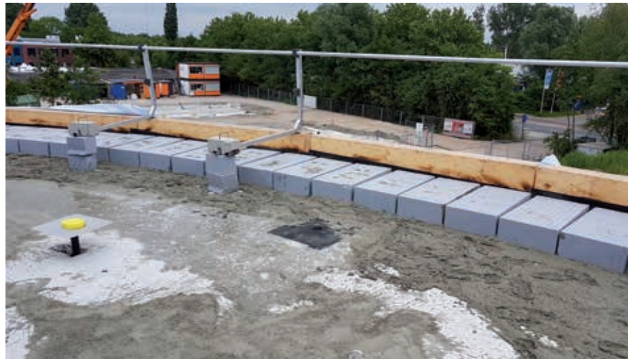
Boven de constructieve dakvloer kwam een isolatiesysteem onder afschot: EPS- en PIR-isolatieplaten van verschillende dikte, opgevuld en afgewerkt met isolerende mortel.
