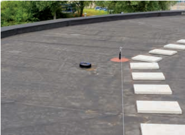
Het dak van het zorgcentrum heeft een R_c -waarde van 6 \text{ m}^2 \text{ K/W} .
