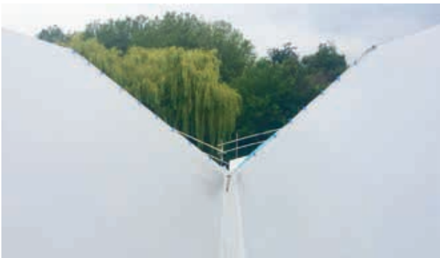
In totaal wordt ongeveer 3.450 m 2 bedekking aangebracht.
