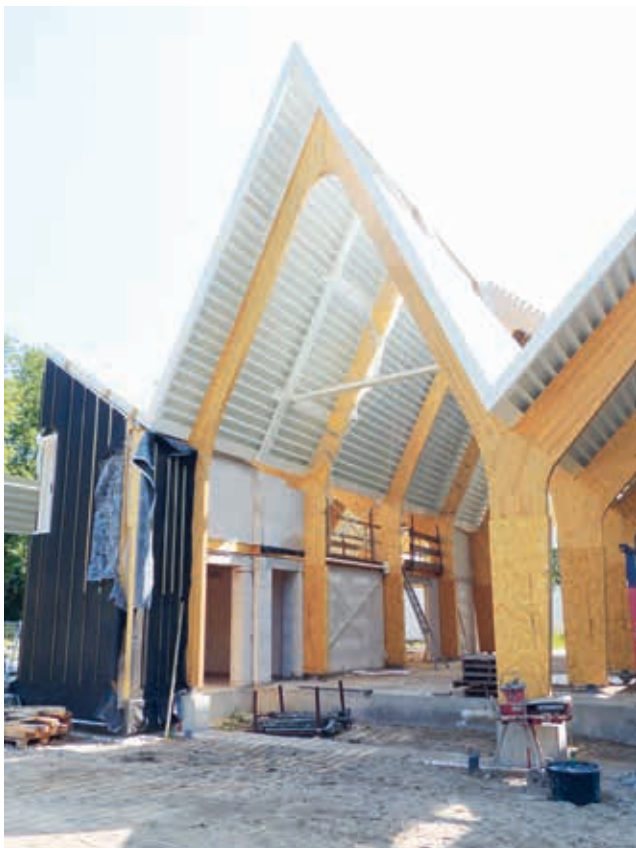
Het dorpshuis is met mens- en milieuvriendelijke materialen gebouwd. Gelamineerde houten spanten, die in het zicht blijven, ondersteunen het dak.
