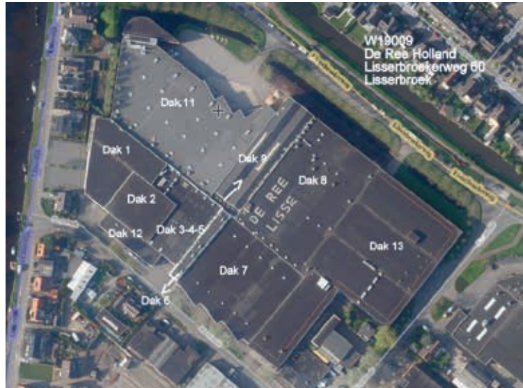
De tweede locatie, de hoofdlocatie aan de Lisserbroekerweg 60, bestaat uit dertien dakvlakken met een totale oppervlakte van bijna 28.000 m 2 .
