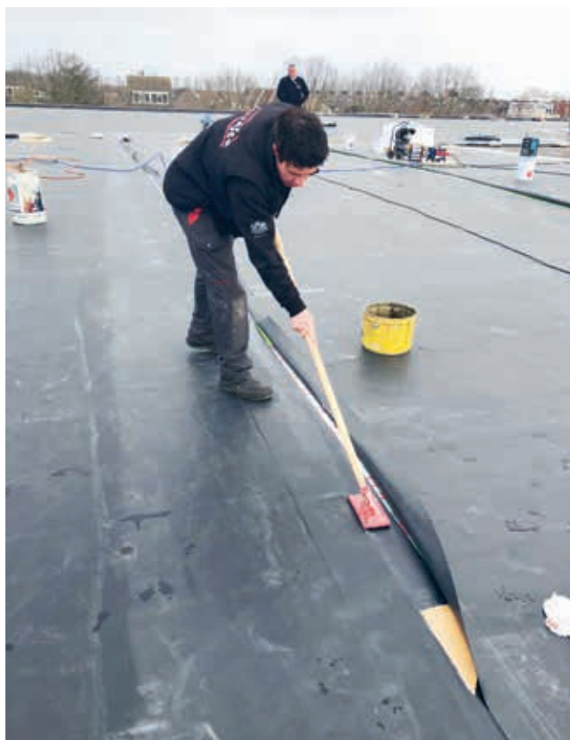
Bovenop de isolatie kwam EPDM dakbedekking van 1,5 mm dik.
