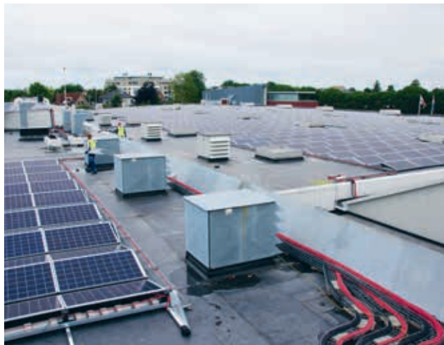
De daken zijn na renovatie allemaal op een R_c -waarde van 6 uitgekomen.
